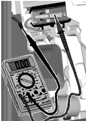
Messung des Ionisationsstromes Bild 10.3.g
